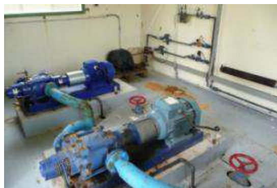
Fig. 2-e : Pompes de refoulement vers le réservoir
