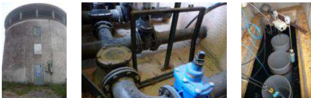
Fig. 2-b : Réservoir – Chambre de vanne du réservoir – Sondes de niveau du réservoir
